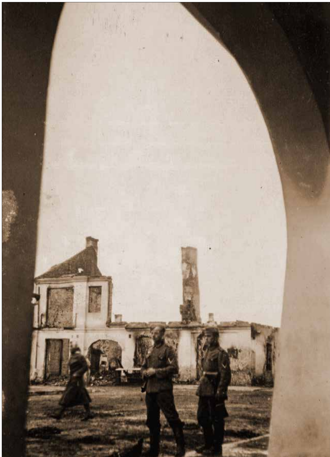
Widok zniszczonego Tomaszowa, październik 1939 r. View of destroyed Tomaszów, October 1939.
