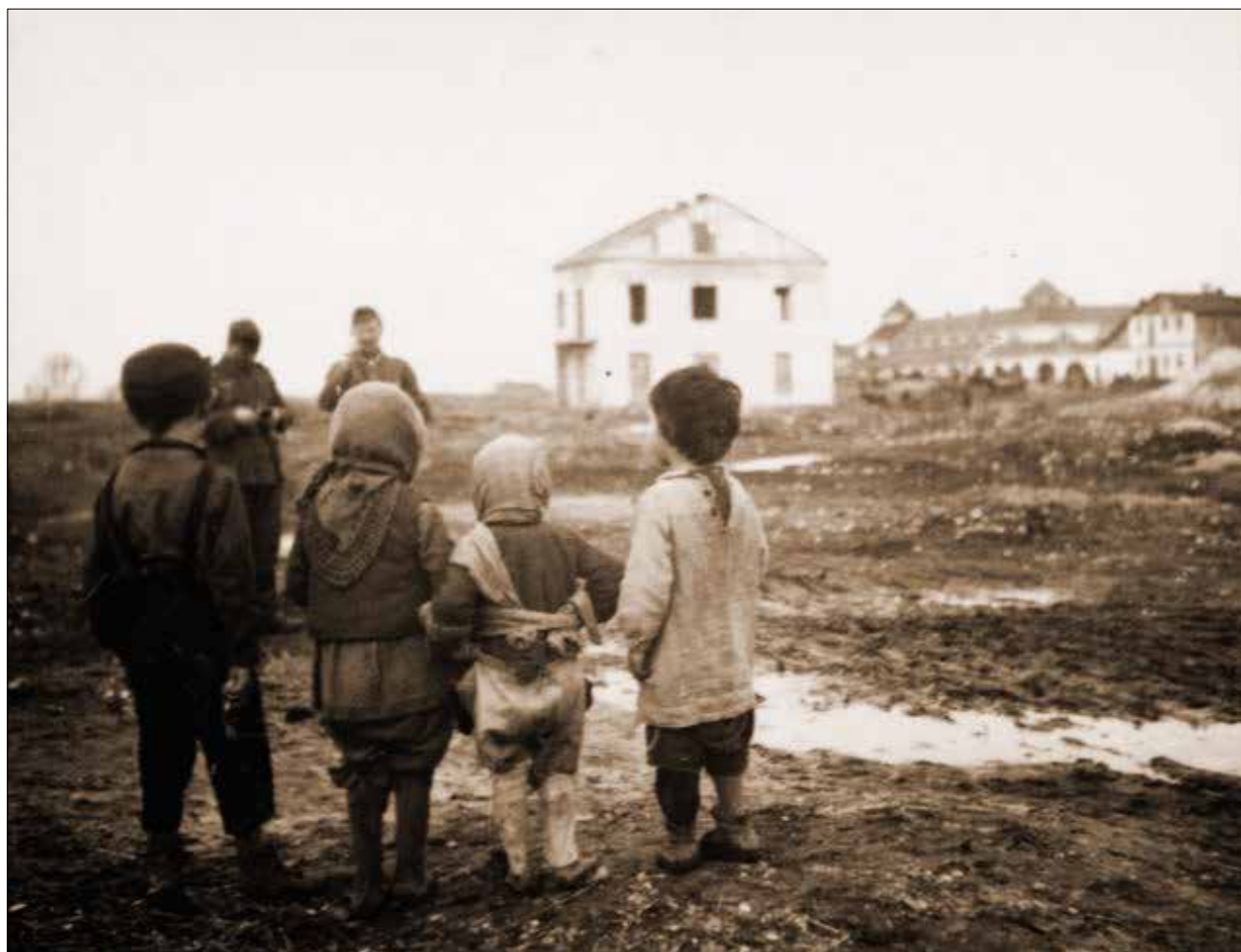
Widok zniszczonego Tomaszowa, październik 1939 r. View of destroyed Tomaszów, October 1939.
