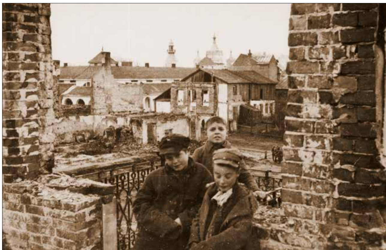
Widok zniszczonego Tomaszowa, październik 1939 r. View of destroyed Tomaszów, October 1939.
